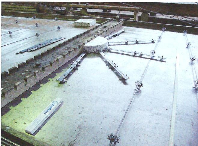
Die Montage des „PSB-F“-Systems ist auf Fertigteilwerke mit einem hohen Rationalisierungsgrad ausgerichtet. Zunächst werden die Langlochleisten verlegt.
