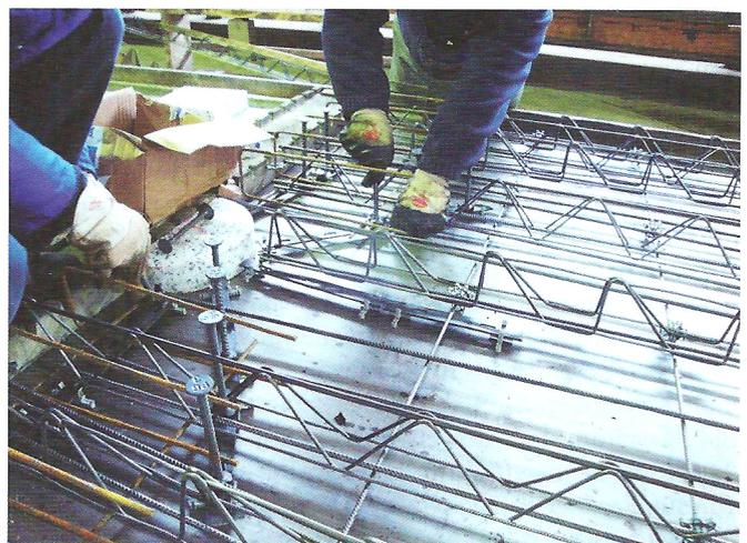
Erst nachdem die Bewehrung platziert wurde, werden die Bolzen des „PSB-F“-Systems auf die Langlochleisten geklickt.
