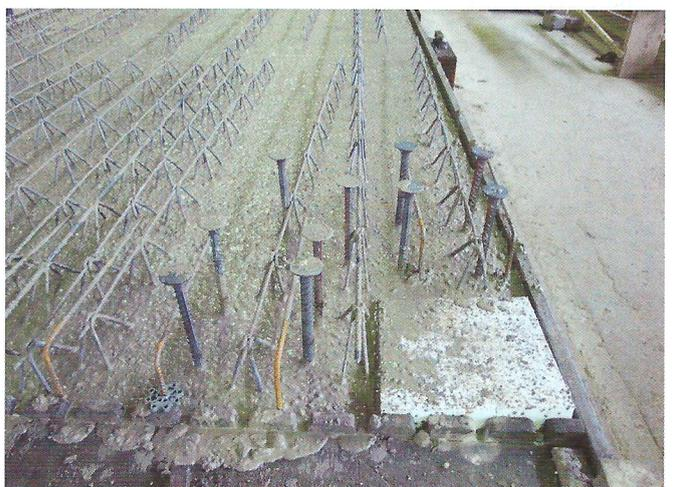
Zum Schluss wird das Deckenelement betoniert.
